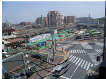
写真 駅前広場はいま 地下駐輪場の工事が真っ盛り
