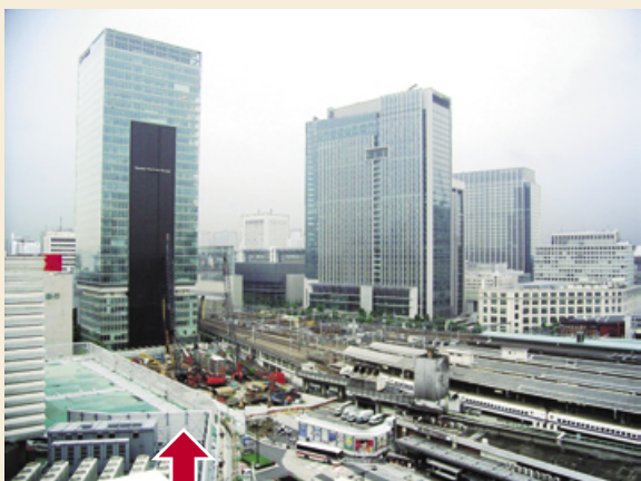
ツインタワー南棟予定地
