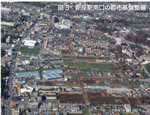
図3: 新座駅南口の都市基盤整備
