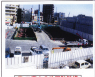
③ 工事中の地下駐輪場
