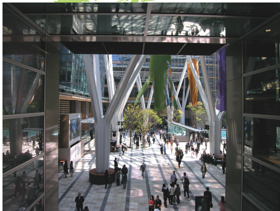
GALLERIA から入口正面を望む
