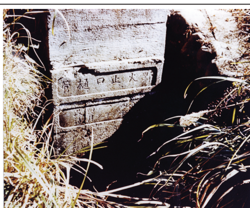
野火止用水取入れ口 明治 41 年 4 月改造と 刻まれた石の取入れ口
