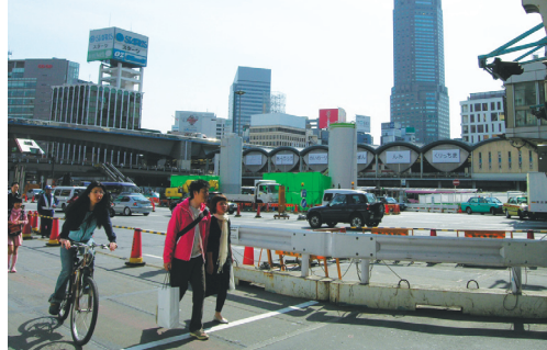
工事中の渋谷駅東口
