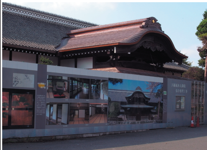
平成23年3月に修復工事が終了予定の川越城本丸御殿
