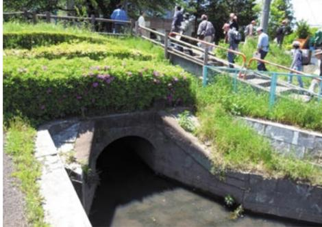
籠馬門樋は、当時の人間郡宗岡村が県の技術指導と県税の補助を得て建設した。下流側には、現在スライドゲートが取り付けられているが、当初は木製の観音開きの戸で、戸の上の石に「籠馬門樋」と刻まれた。アーチの石組みは、五角形の切石積み、西洋の煉瓦・石造り建築にみられる方式で、日本古来のアーチとは異なっている。石造りのアーチ型樋門としては県内唯一のものなので、志木市の文化財として指定すべきだ、という声が高い。
