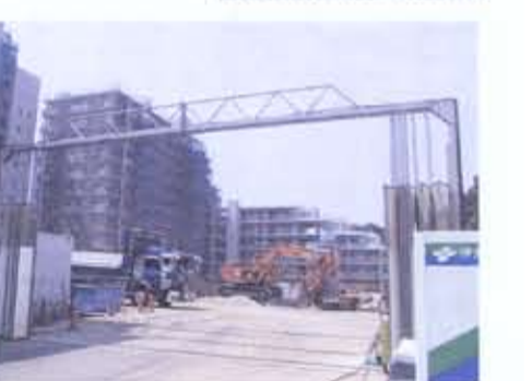
上写真 「ハケの山」開発の現場 右下写真 東武東上線の線路に沿って建設されるマンション582戸 下写真 かつてのハケの山
